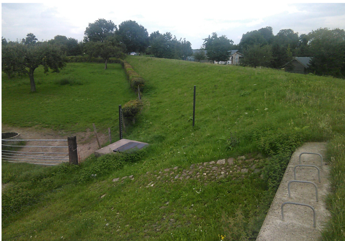
Figuur 2.6: Spoelgoot en Duiker met terugslagklep in dijkvak 50.410.10
