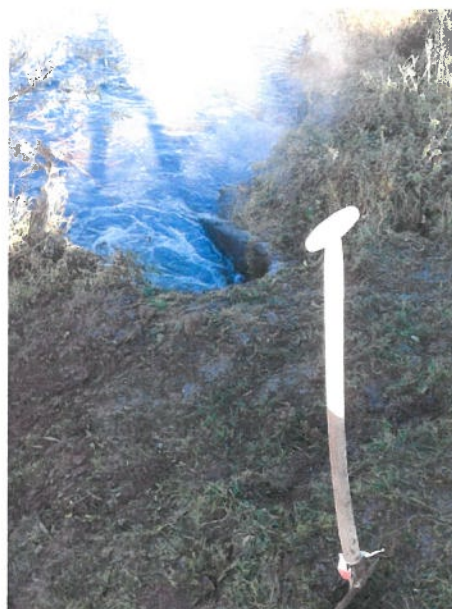
Afbeelding 2, Overzicht boorlocatie na werkzaamheden
