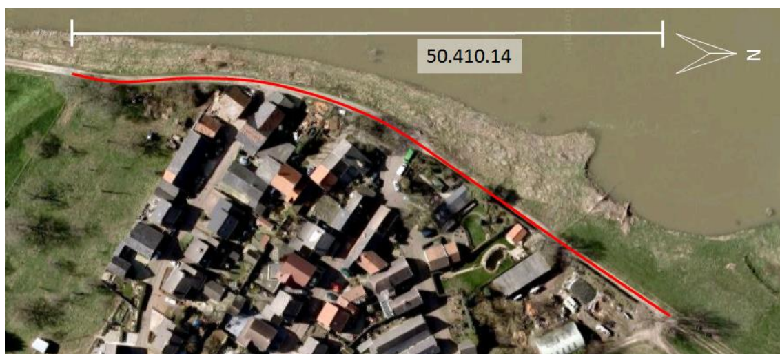
Figuur 3.22: Situatie dijkvak 50.410.14
