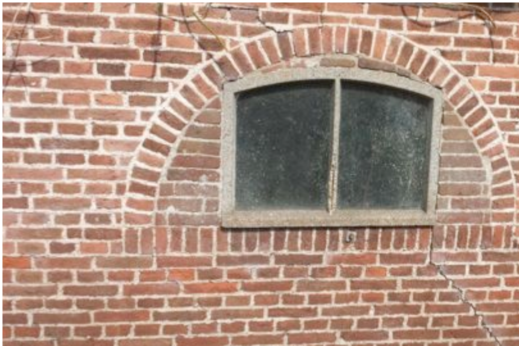
bestaande gevelmetselwerk - kruisverband - gemelleerde kleur stenen - handvorm steen - lichte voeg platvol
