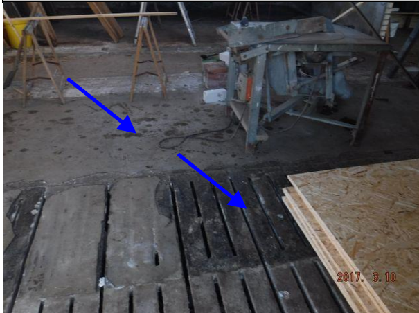
Bitumen lijmlaag op vloer en betonroosters in schuur 2
