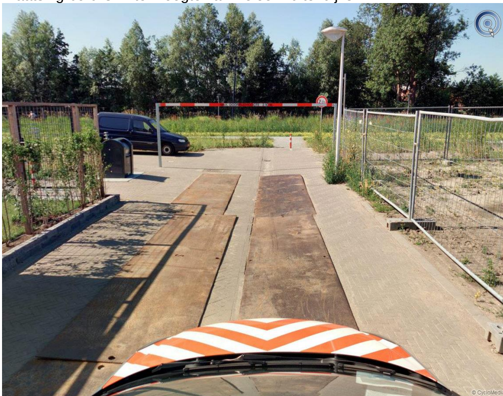
Plaatsing bord C21 en hoogtebegrenzer parkeerplaats Beleef Buitendijks
