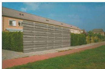
Niet passend door hoogte en geen afstemming van het materiaal- en kleurgebruik.
