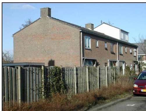
Dakopbouwen zijn mogelijk op zadeldak met hellingshoek gelijk aan of kleiner dan 35°. Maar dan wel door het verlengen van het voordakvlak, waardoor de nok naar achter verschuift (dus dakopbouw gericht op achterzijde).
