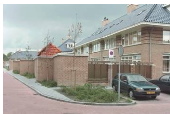
Niet passend door afwijkende kapvorm.
