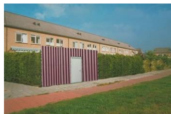
Niet passend door een afwijkend materiaal- en kleurgebruik.
