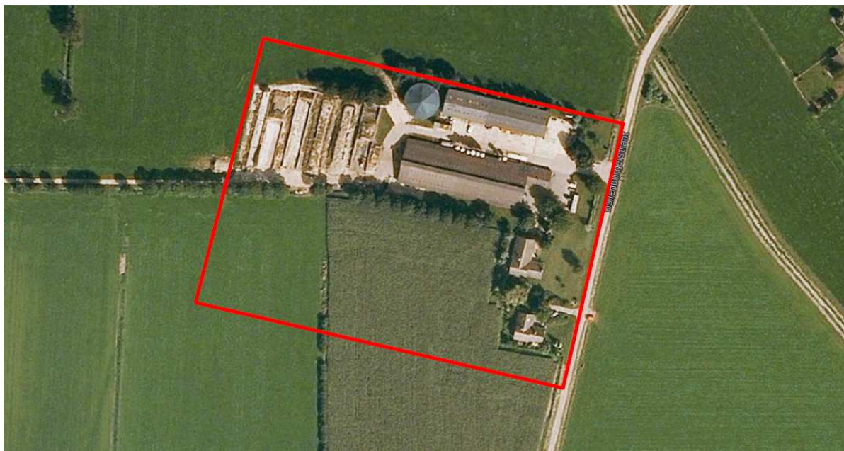
afb. bestaande situatie bebouwing agrarisch bouwperceel
