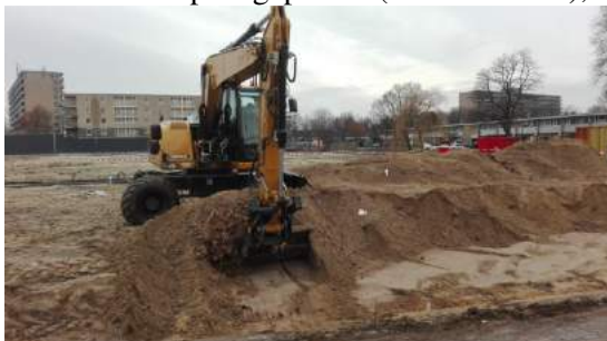
Foto 1: ontgraven 0,0- 0,8 m-mv
