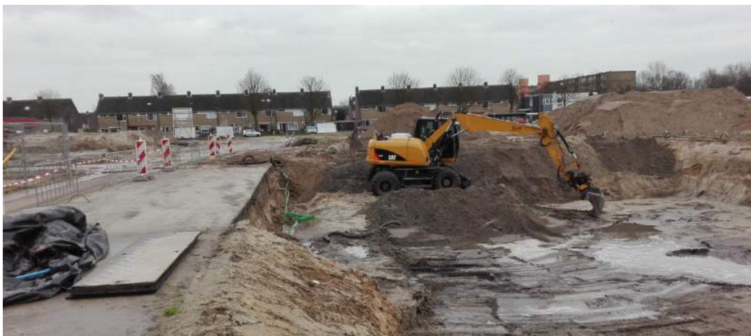
Foto 5: ontgraven tot op de veenlaag
