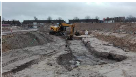
Foto 4: ontgraving zijde voormalige shop
