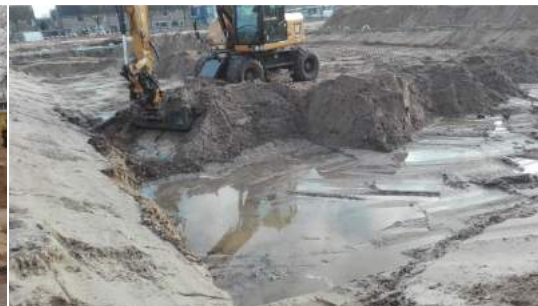
Foto 2: ontgraven 0,8-1,5 m-mv
