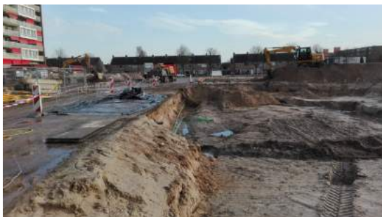
Foto 3: ontgraving zijde Tannhäuserstraat
