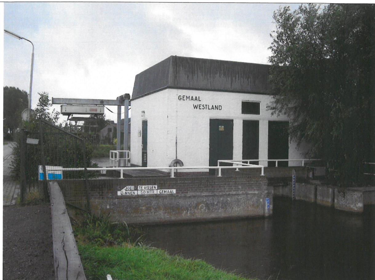
Bijlage 1, Gemaal Westland Behorende bij melding Besluit voorzieningen en installaties milieubeheer
