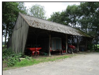
Figuur 4. De te slopen kapschuur.
