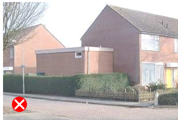
zijaanbouw te hoog
