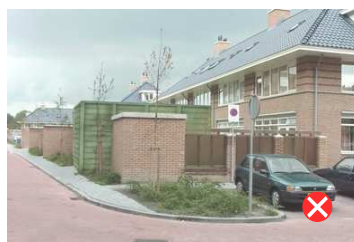
sterk afwijkend materiaalgebruik
