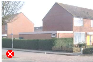
zijaanbouw te dicht bij voorgevelrooilijn
