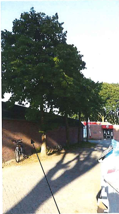
Bestaand kleedkamer gebouw
