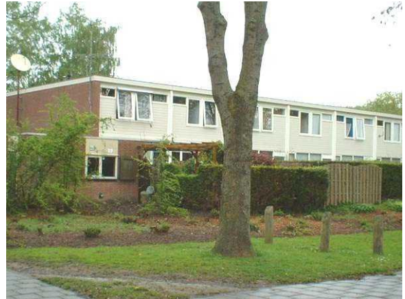
Oorspronkelijke, thans gerenoveerde strookbebouwing, Lucernehof.
