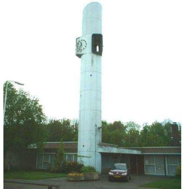
Een kerktoeren opgebouwd uit beton-/gipselementen met klok als uitkraging, Westerrand, Espel.
