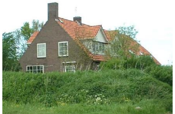
Soms opvallende dakkapellen bij langgevel boerderijen.
