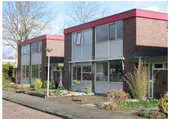
Gevels met puivullingen, de Ring.
