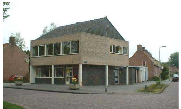
Bijzondere voorzieningen waren redder voor een afwijkende vormgeving, Voorstraat, Kraggenburg.
