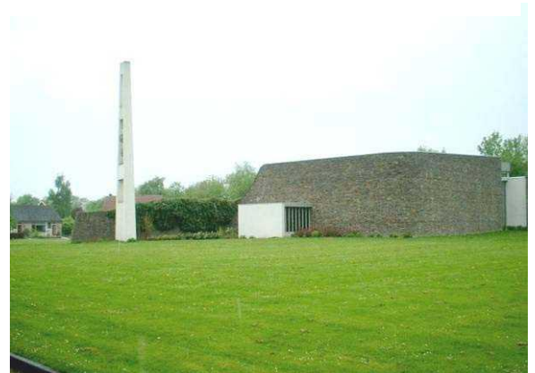
De kerk in Tollebeek heeft een gebogen, gemetselde wand. Gezien vanaf Hertshoren.
