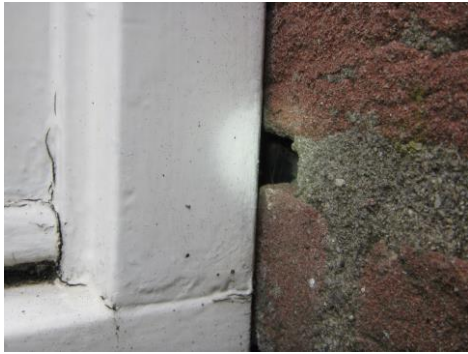
onderzoek spouwmuur / Foto M
