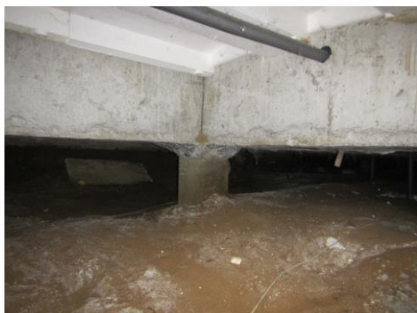
onderzoek kruipruimte / Foto K
