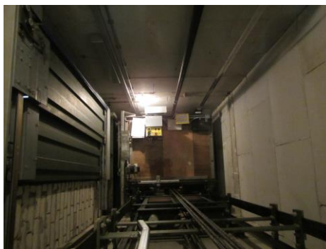
onderzoek liftschacht / Foto L
