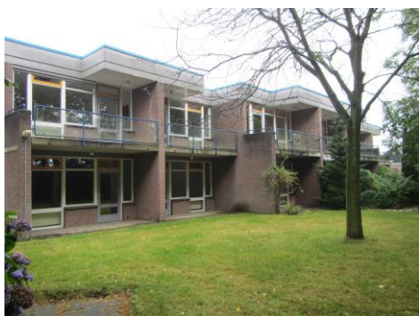
achterzijde appartementencomplex / Foto G
