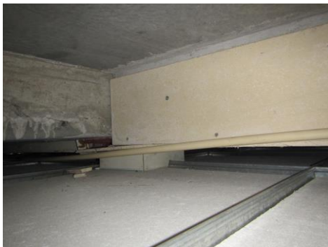
niet verdachte brandwerende beplating om stalen balken / Foto Q
