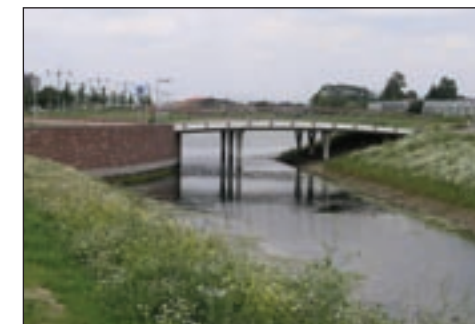
foto: aanlandingspunt bruggen in schoon metselwerk
