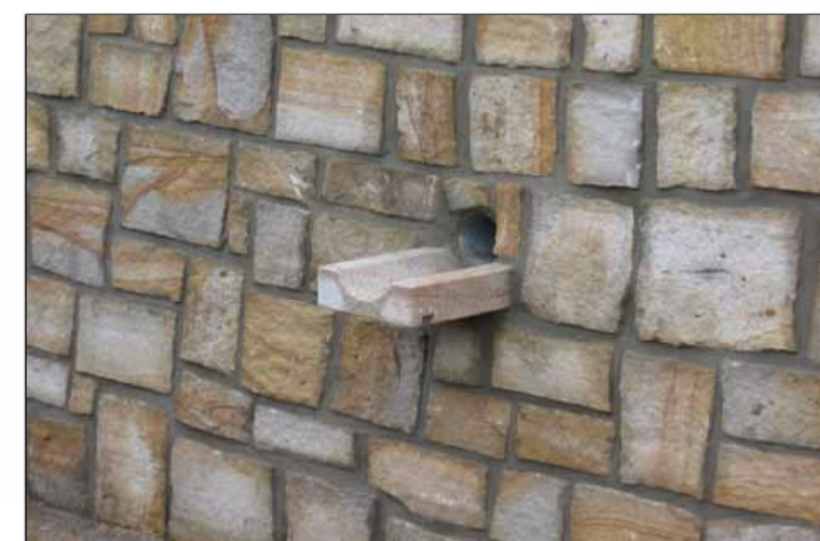
Leksteen in kademuur
