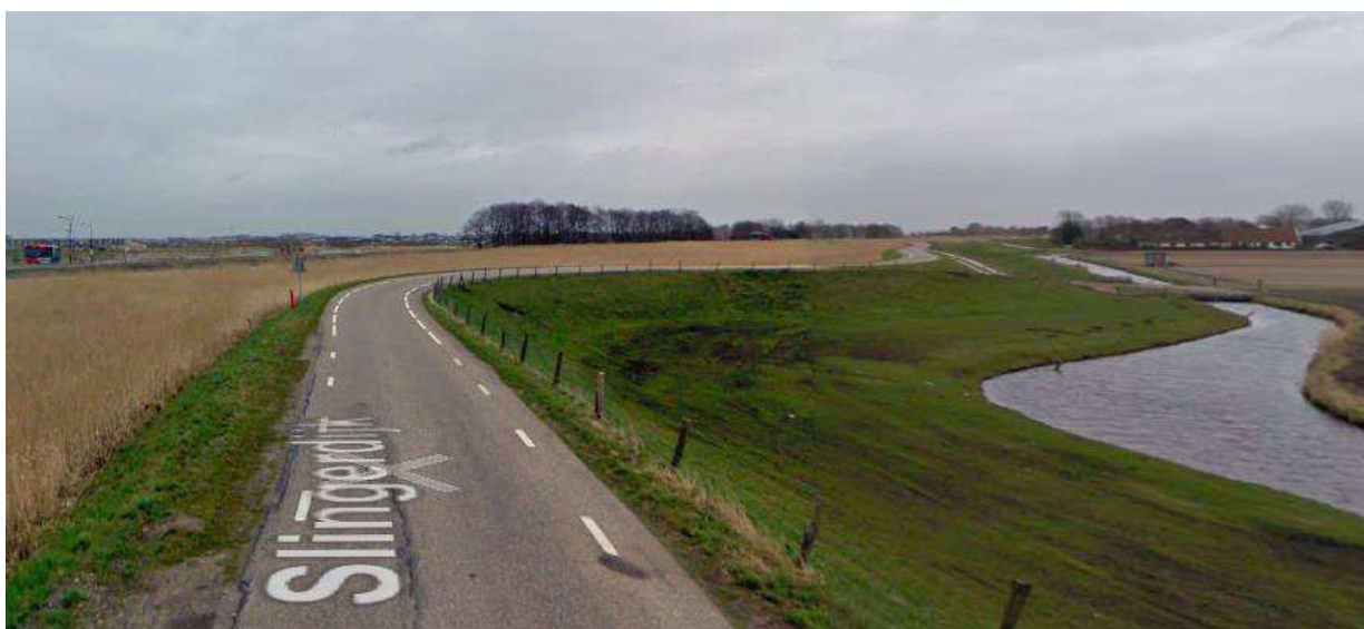
Figuur 5.1: Slingerdijk in sectie 11 met weg op kruin en steil binnentalud (Google)
