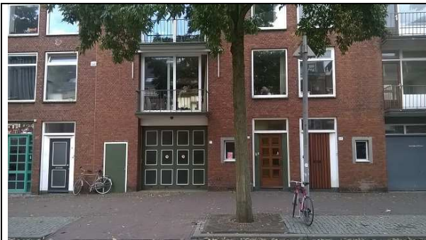
Nieuwstraat 37-45 (mogelijke HBO-tank bij woning).
