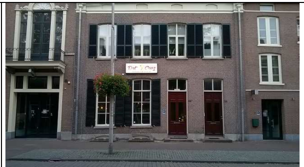
Nieuwstraat 52-54 (ondergrondse stookolietank).
