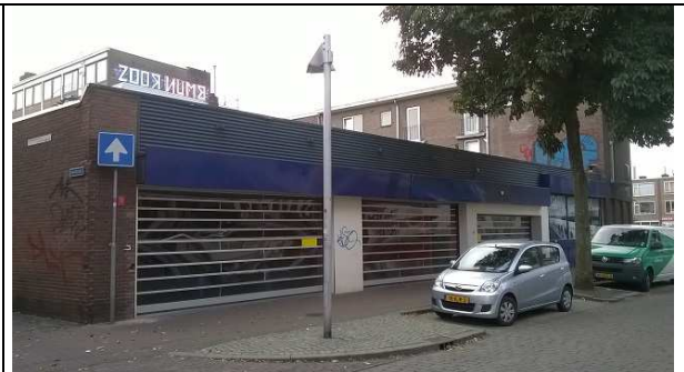
Nieuwstraat 25, ondergrondse stookolietank.
