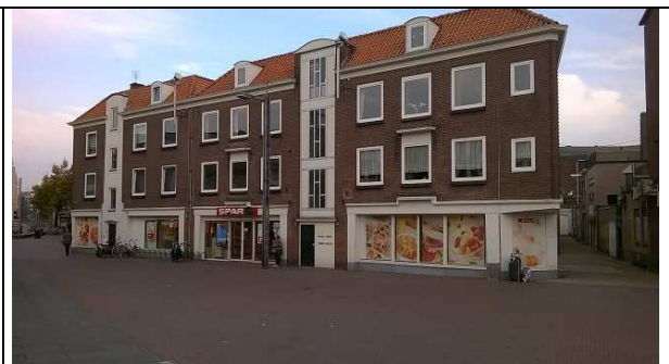
Broerenstraat 7-13, ommuurde stookolietank in kelder.
