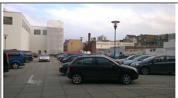
Parkeerdek ondergrondse parkeergarage Broerenstraat.
