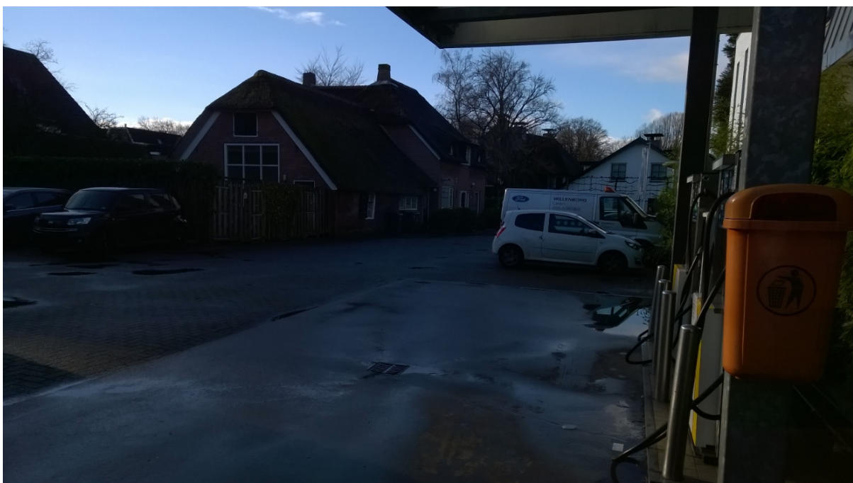
Foto 2: 1 afvoerput op de vloeistofdichte vloer. Woning met rietenkap.
