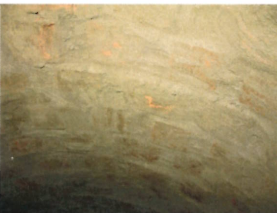
Metselwerk na neutralisatie, wederom platvol gevoegd
