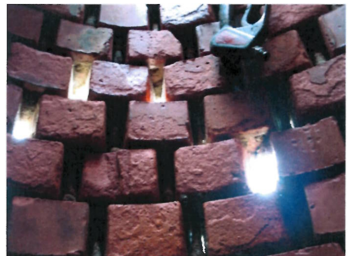
Metselwerk na neutralisatie, wederom platvol gevoegd
