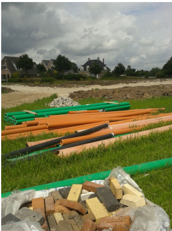
PVC rioolbuizen voor vuilwater (bruin) en afgekoppeld hemelwater (groen)
