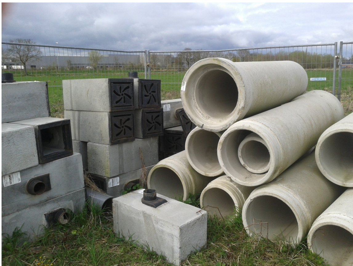
Betonnen rioolbuizen en straatkolken met waaier deksel (afgekoppeld hemelwater)
