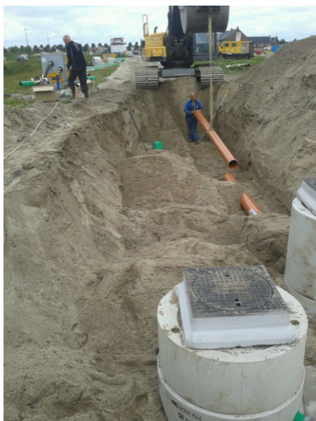
Aanleg riolering Stationskwartier
