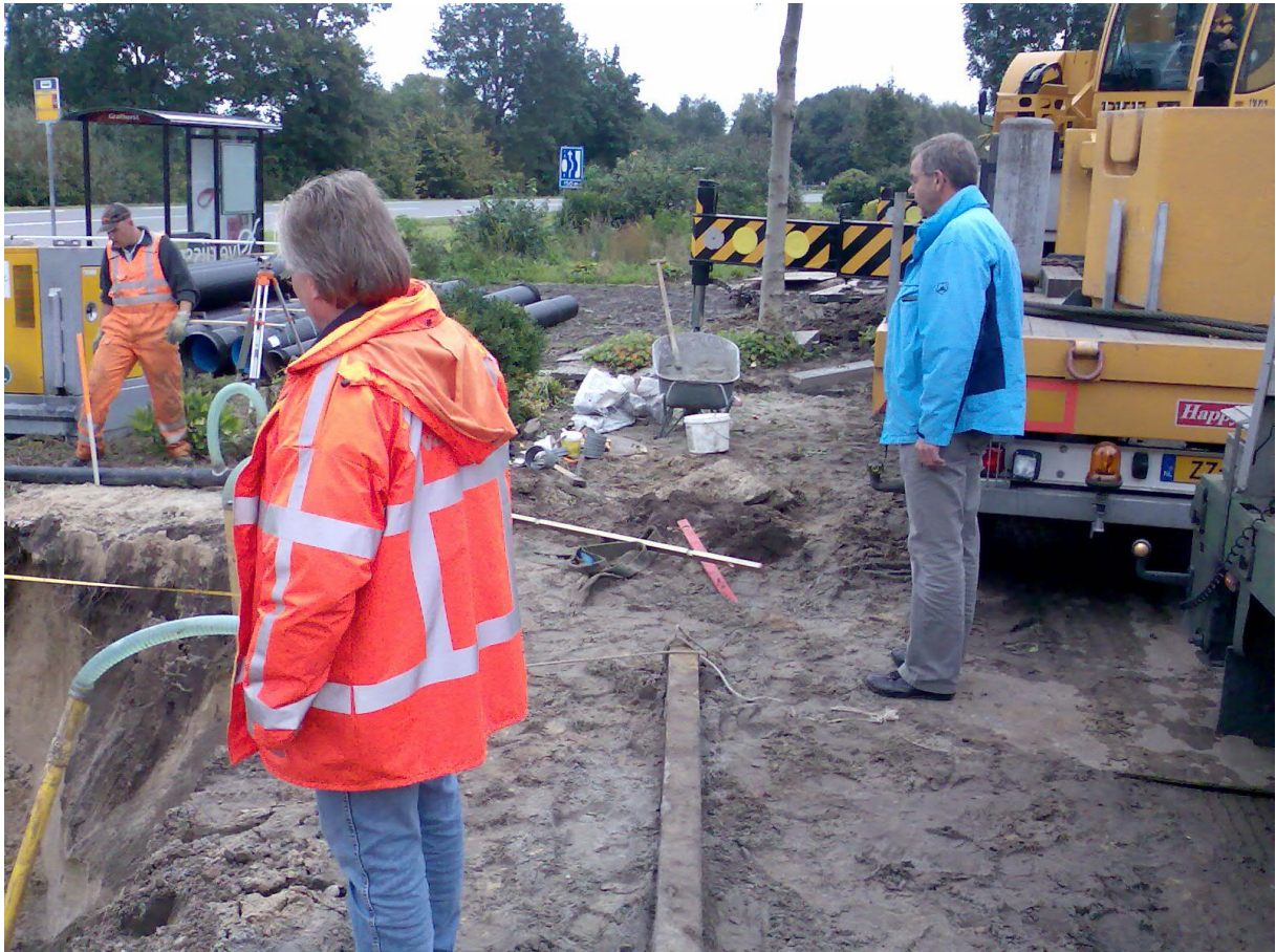
Uitvoering en toezicht bij de aanleg van Bergbezinkleiding in Grafhorst
