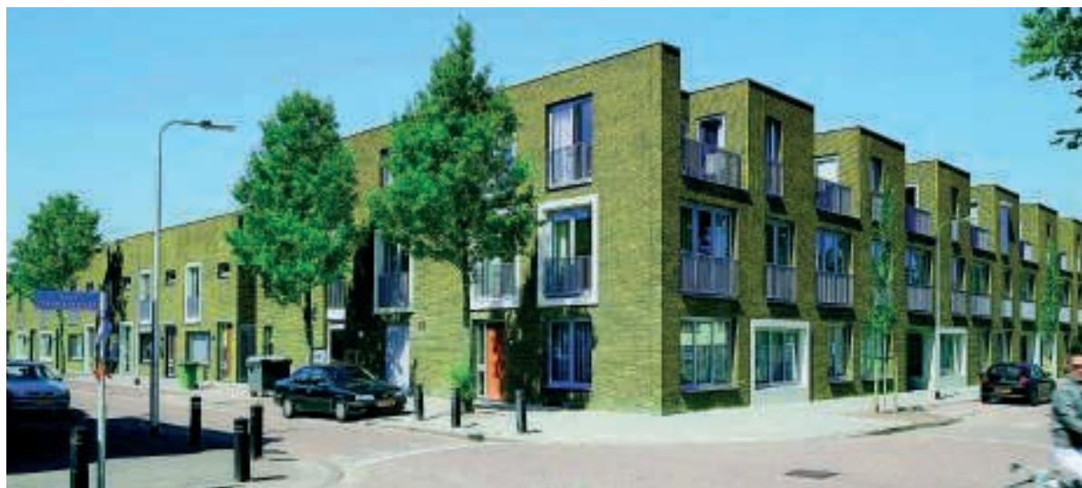
Aaneengesloten bebouwing, de overgangen / aansluitingen tussen verschillende functies worden zorgvuldig opgenomen in het ontwerp Dit leidt tot hoekoplossingen waarbij zijgevels representatief zijn en tuinmuren als integraal onderdeel van de architectuur
