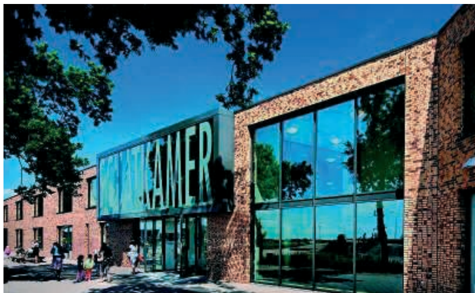
Door de eenheid in kleur en materiaal worden de gesloten bouwblokken als architectonische ensembles ervaren. Gevels met veel glas ter plaatse van publieke voorzieningen en de overgang naar de woonfuncties met minder glas.
