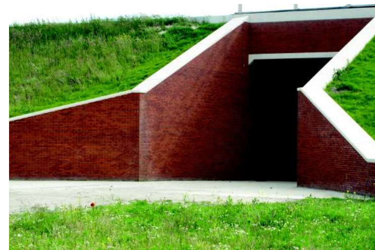
fietstunnel onder de spoordijk Hanzelijn
