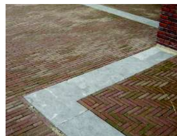
referenties bestratingsmateriaal: gebakken klinkers met hardsteen, merwebasalt stoeptegel en betonstraatsteen met basalttoeslag
