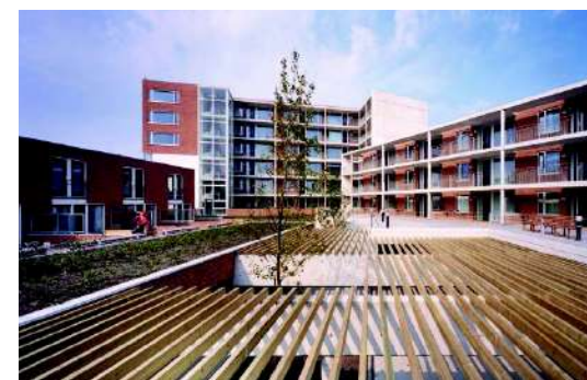
referentie dak garage met sedum en lamellen
