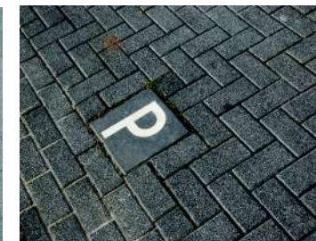
referenties bestratingsmateriaal: gebakken klinkers met hardsteen, merwebasalt stoeptegel en betonstraatsteen met basalttoeslag
