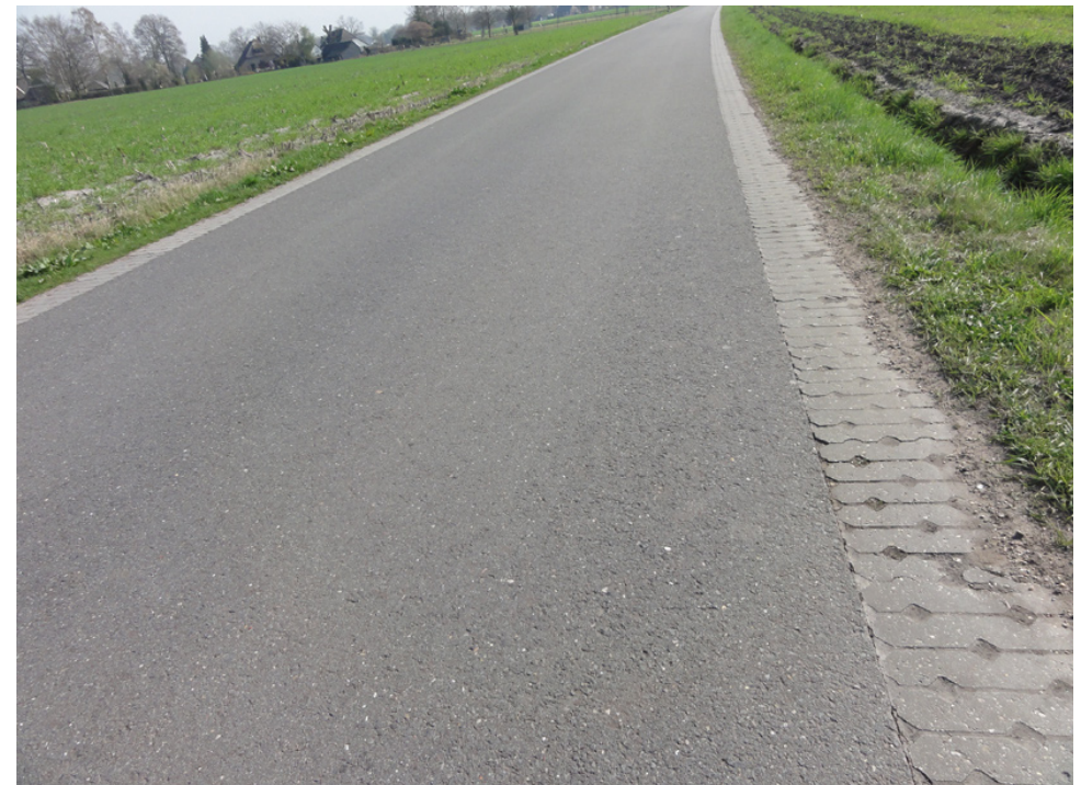
toegangsweg met bermbetonsteen
