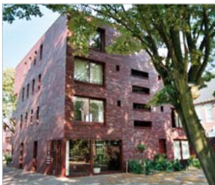
raamopeningen in de zijgevel
