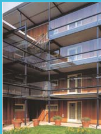
galerijen aan het binnenterrein
