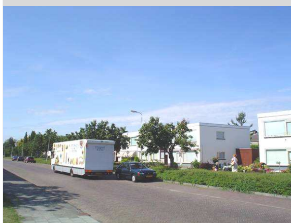
Diverse bebouwingstypologieën: vier lagen met een gesloten plint onder een plat dak en de rijtjeswoning met een zadeldak (boven). Maar ook rijtjeswoningen met platte daken komen voor (onder).
