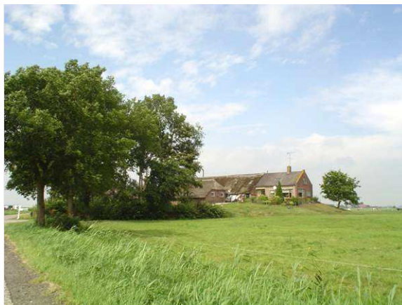
Het woon- en bedrijfsgedeelte onder dezelfde noklijn.
