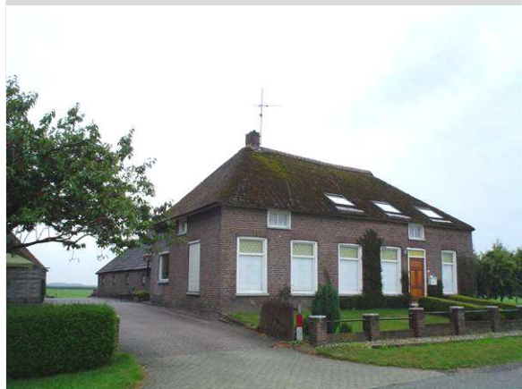
Boerderij met dwars geplaatst woonhuis, onder een schilddak.
