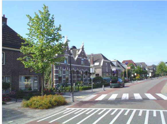
De detaillering in de periode van de neorenaissance (twee tuitgevels boven) is aanzienlijk fijner dan in de nieuwbouw periode.
