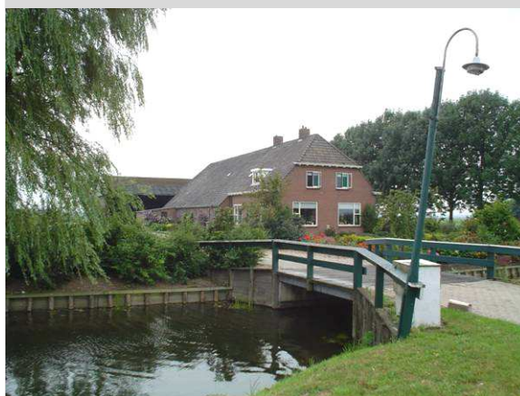
Boerderij met afgewolfd zadeldak en krimp. Het woon- en bedrijfsgedeelte zijn onder een doorlopende kap samengebracht. Kenmerkend is ook de brug naar het erf.
