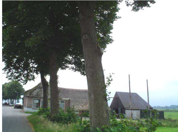
De omgekeerde situatie: het hoofdgebouw is groter dan het bijgebouw.
