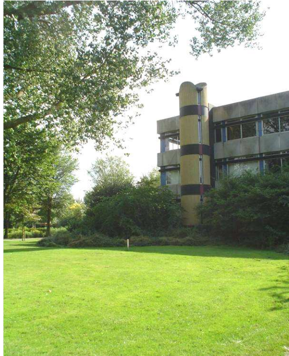
Het voormalige kantoor van de belastingdienst wordt gesloopt.
