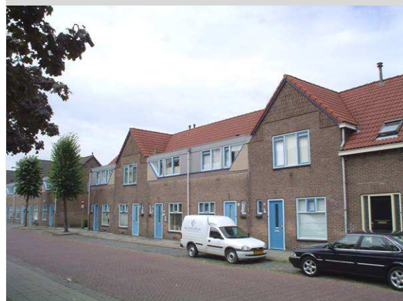
Veel oorspronkelijke detaillering is verdwenen of veranderd.
