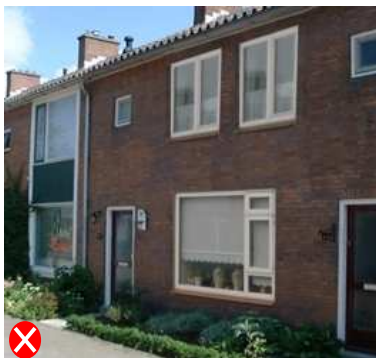
fig. 9 samenhang straatbeeld verstoord door afwijkend kozijn
