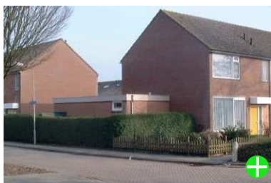
fig. 4 goed geplaatst, passende vormgeving en materiaaltoepassing
