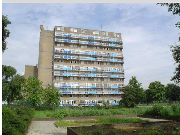
Grotere structuren als scholen (boven) en flatgebouwen zijn alzijdig ontworpen en in een groene omgeving gesitueerd.
