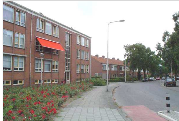
Diverse kapvormen in Oranjedorp (boven). Zadeldaken en een plat dak in de Vogelbuurt (onder).
