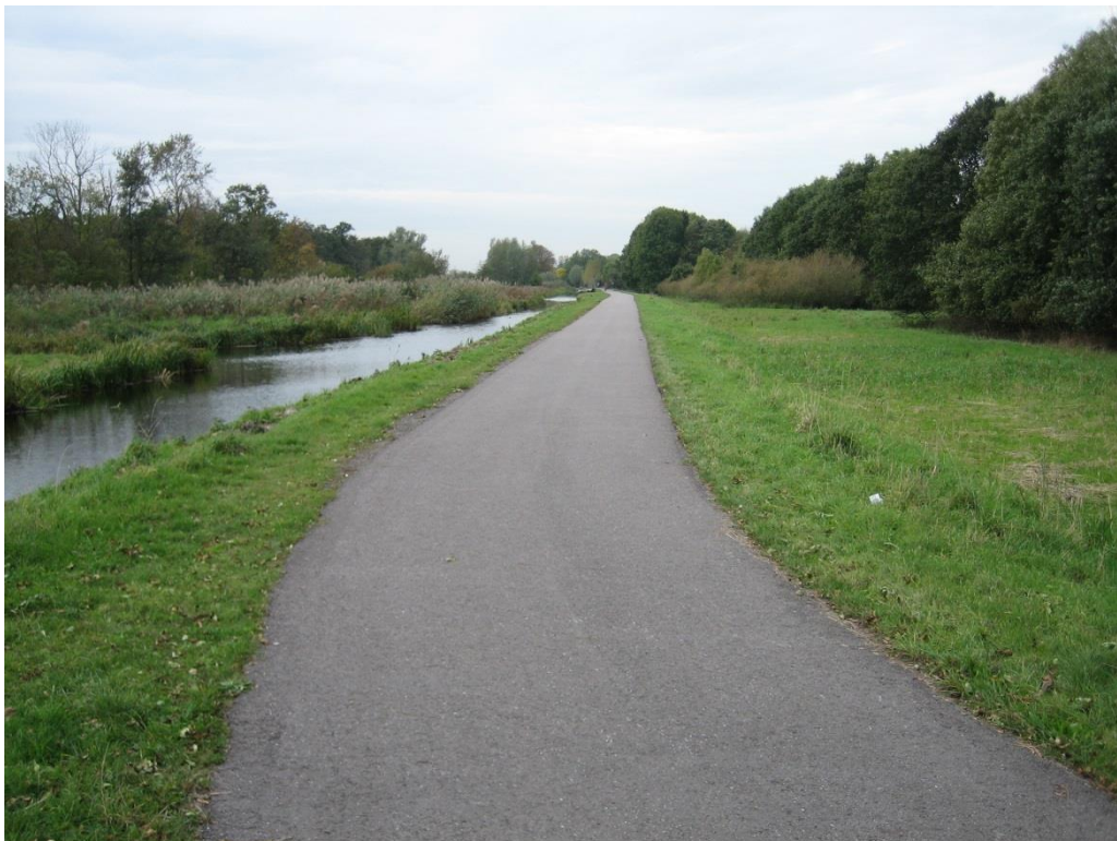
Ackerdijkseweg gezien in westelijke richting. Deze kade blijft onveranderd.
