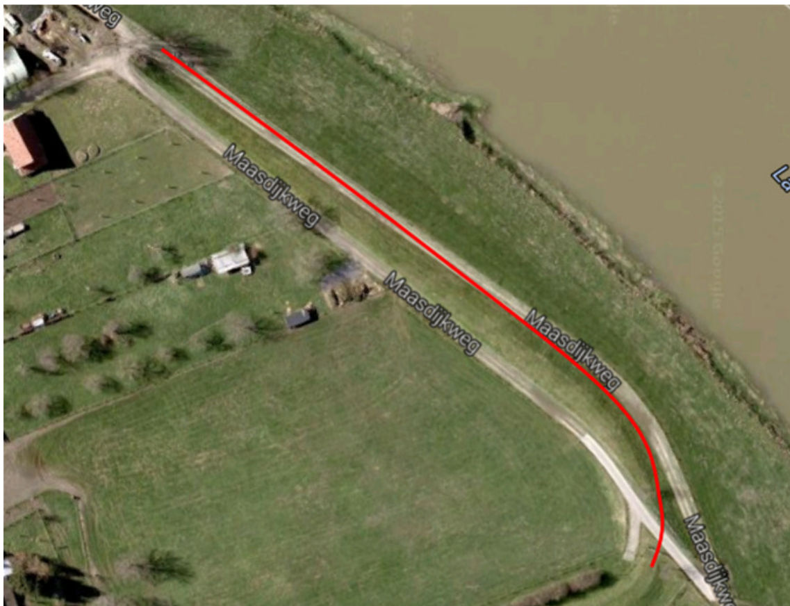
Figuur 4.8: Bovenaanzicht dijkvak 50.410.15
