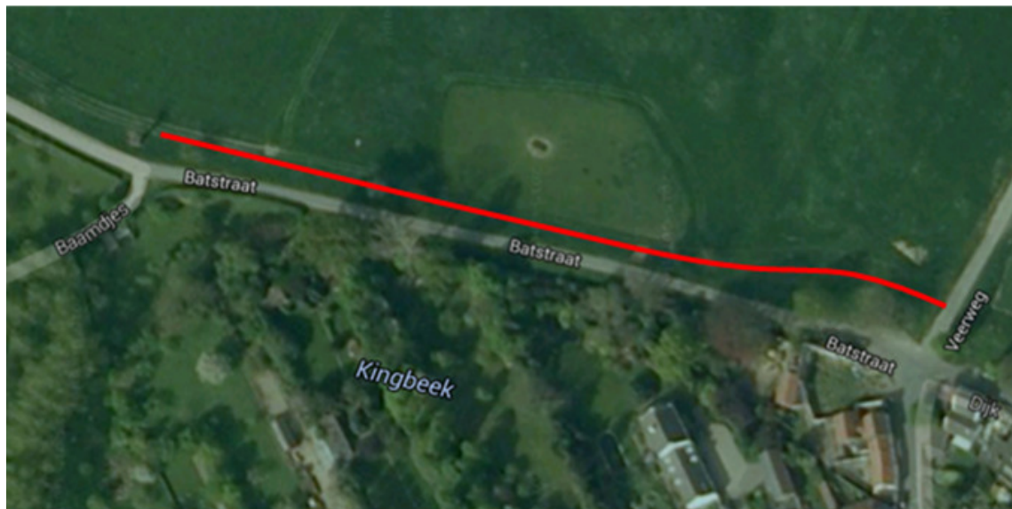
Figuur 5.5: Bovenaanzicht dijkvak 50.510.12
