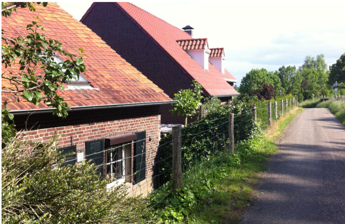
Figuur 2.2: Bebouwing in dijkvak 50.550.4 (Ruitersbaan 44 en 46)
