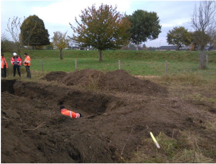
Figuur 4 WBL AC persleiding D = 250 mm
