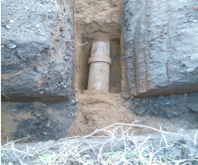
Figuur 2 Bovenaanzicht ontgraving, visueel geen hoekverdraaiing te bepalen
