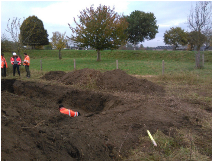
Figuur 4 WBL AC persleiding D = 250 mm
