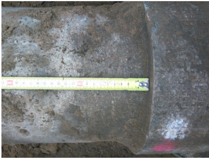
Figuur 6 Komeetkoppeling, L = 13 cm
