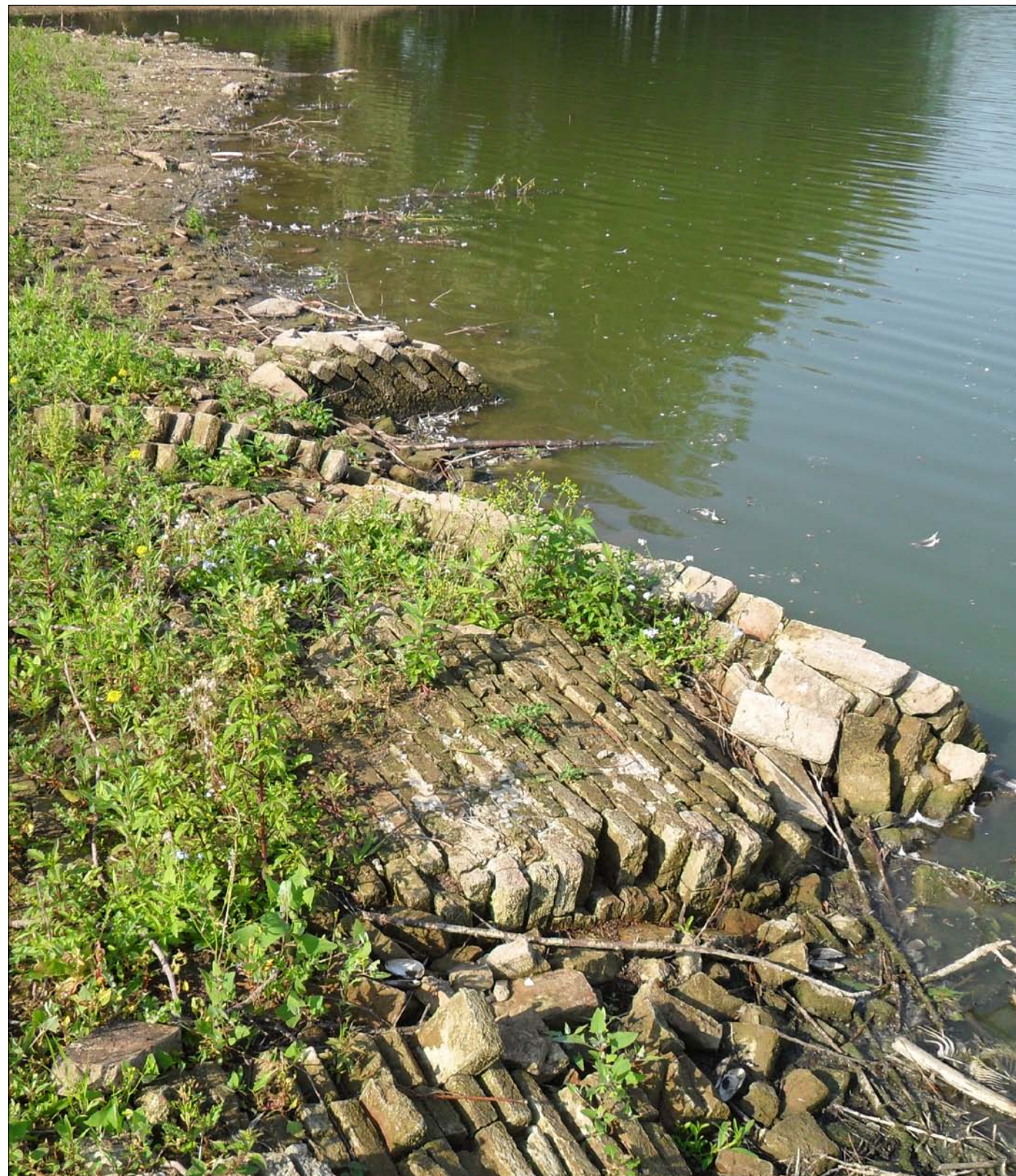
Restanten gevel op oostelijke oever oude strang / Wiel van Doornik v
