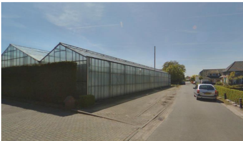
Zicht op de locatie vanaf de Nieuwediep
