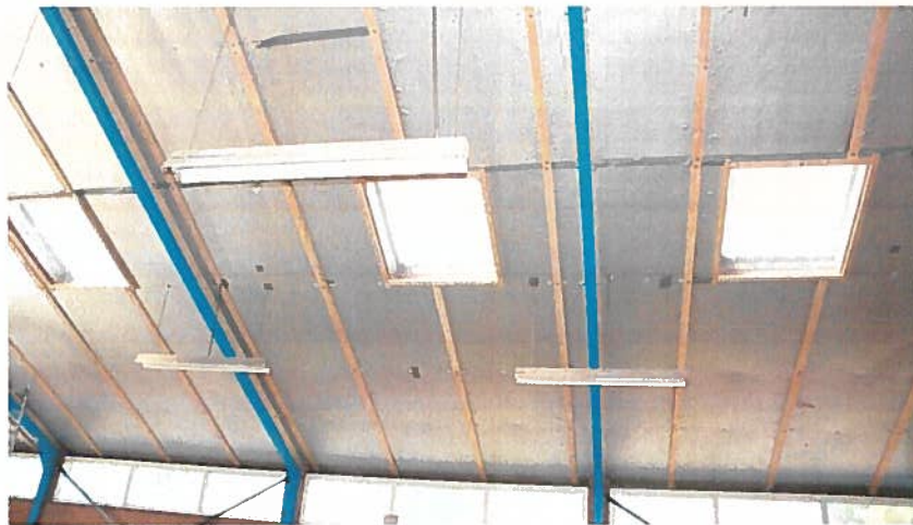
Keurig afgewerkt en geïsoleerd
