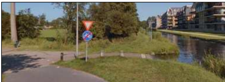
Abbeelding 7. Trailerhelling welke ook verhoogd zal worden. Zie ook dwarsprofiel 105a.
