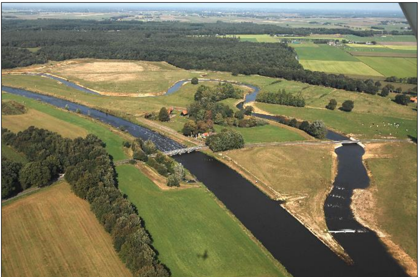
Figuur 1: luchtfoto stuw Junne
