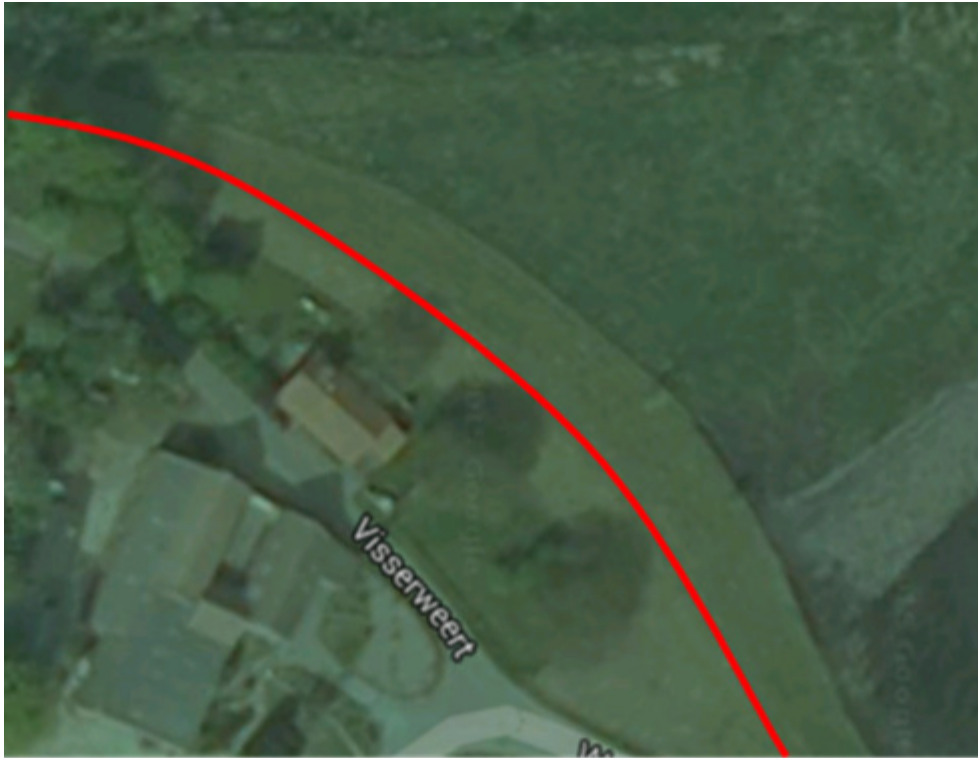
Figuur 8.4: Bovenaanzicht dijkvak 50.540.4
