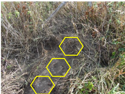
Figuur II-7 Zetsteen bovenaan talud bij 34,5
