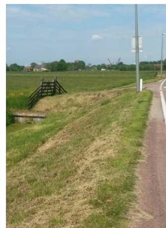
Foto 7: Buitentalud met kort gemaaide berm
