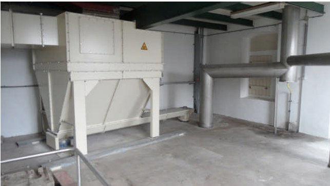
11. Brouhuistoren (3 e bouwlg.)
