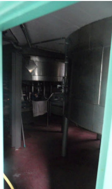
11. Brouhuistoren (1 e bouwlg.)
