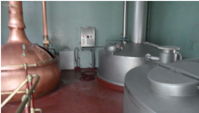
11. Brouhuistoren (2 e bouwlg.)
