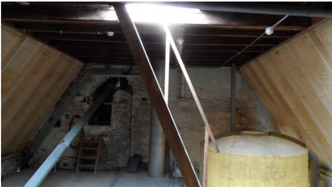
11. Brouhuistoren (5 e bouwlg.)
