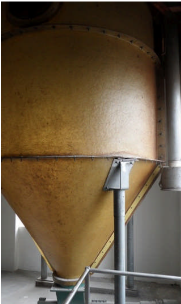
11. Brouhuistoren (4 e bouwlg.)
