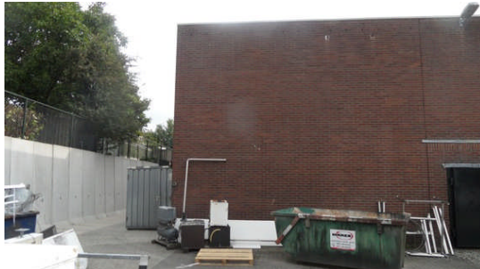
Buitenterrein achterzijde Bouwdeel 1 [lagerkelders] →
