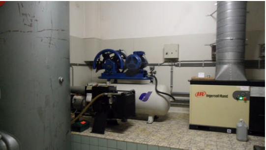
Koelinstallatie- / Luchtcompressorruimten → (2° Bouwlg.)
