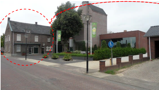
voorzijde Bouwdeel 2 (Ontvangst) + Bouwdeel 1 (Brouwhuis) vanaf Engelmanstraat
