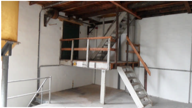
11. Brouhuistoren (4 e bouwlg.)
