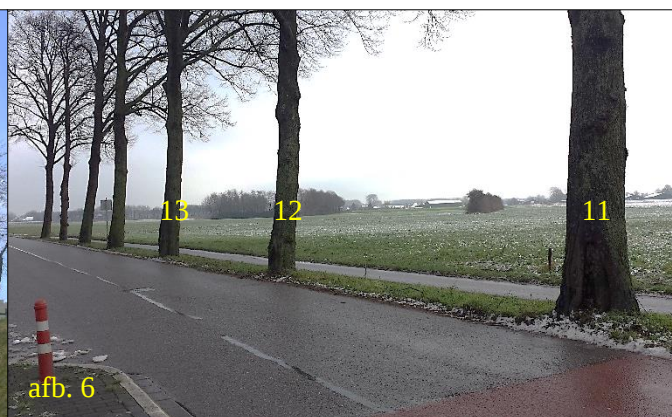
Afbeelding 6; De bomen 11, 12 en 13 zijn door meerdere aanrijdingen fors beschadigd en lokaal ingerot.
