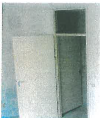
Figuur 37 Een opdekdeur heeft als overstroomvoorziening een doorlaat van 16 \text{ dm}^3/\text{s} , door de spleten langs stijlen en bovendorpel.
