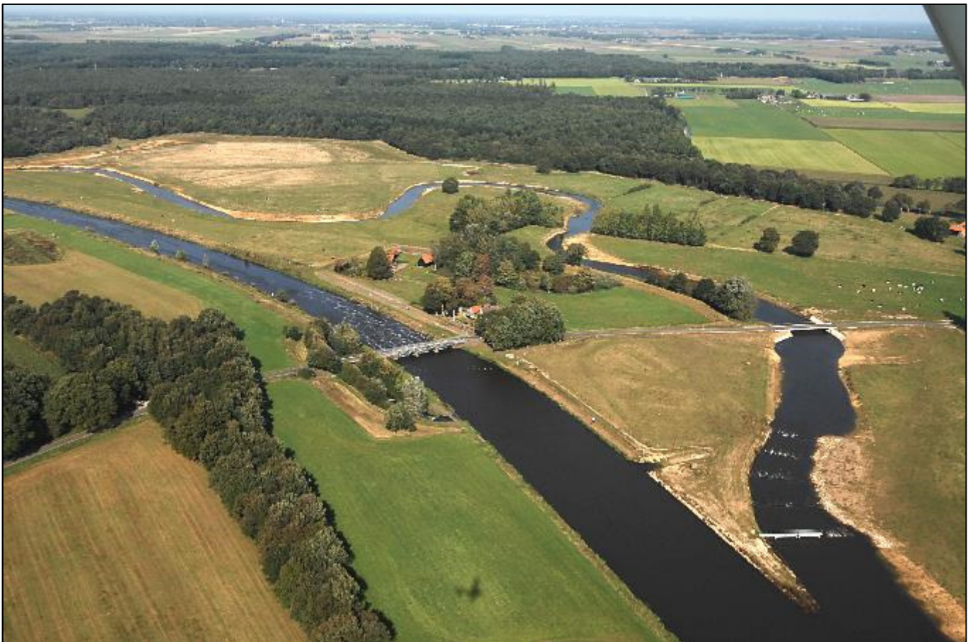
Figuur 1: luchtfoto stuw Junne
