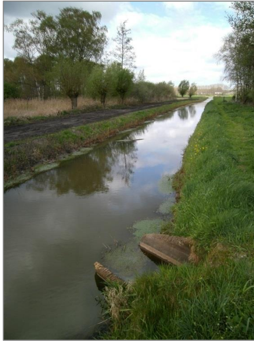
Afvoerduiker (uitstroom) in Elsgraven
