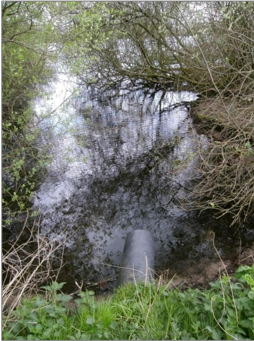
Afvoerduiker (instroom) noordwestkant Enterveen
