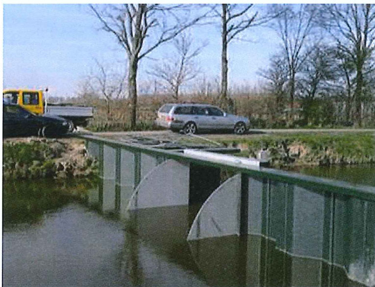
Figuur 9 In kleur uitgevoerde damwand met deksloof
