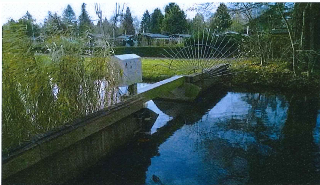
Figuur 3 Foto stuw 19197st met RVS kantelstuwbak + elektrische aandrijving en slootwaaier
