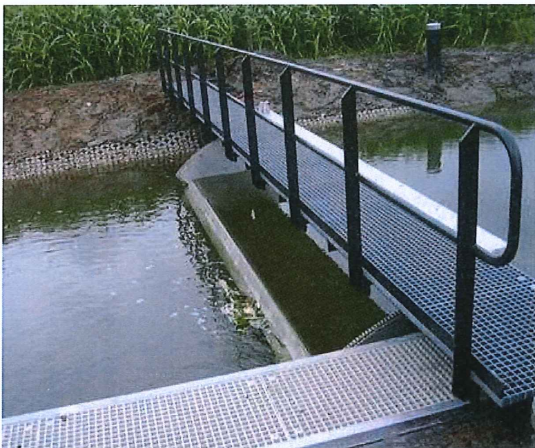
Figuur 8 Kantelstuwbak met kunststof looproosters (Bron: kwtgrou)
