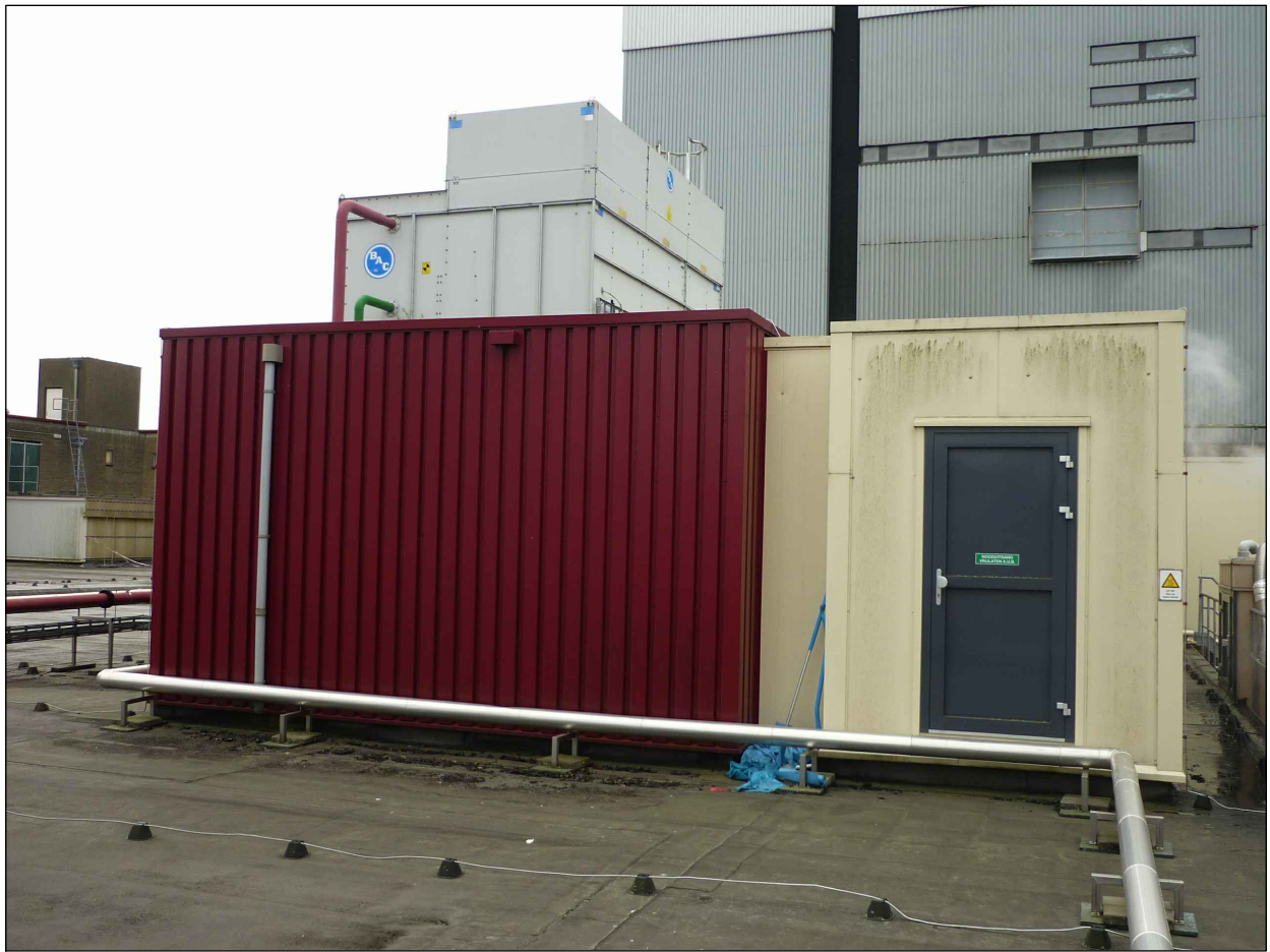
aanzicht trappenhuis / loopbrug
