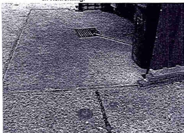
Fotonummer: 5 Omschrijving: Aanzicht betonvloeren.
