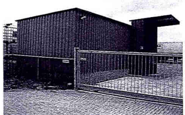
Fotonummer: 2 Omschrijving: Aanzicht bovengrondse dieselopslag.
