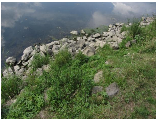
Figuur II.10 Stortsteen onderaan het talud bij 49,2
