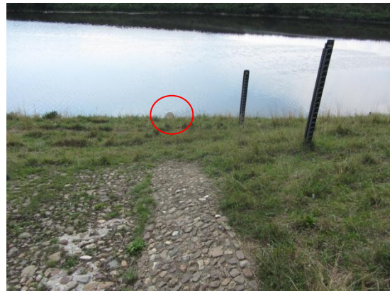
Figuur II.6 Bekleding waterafvoer (rode cirkel is de afvoerpijp uit de dijk)
