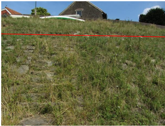
Figuur II.5 Zetsteen onderaan het talud tussen 49,0 en 49,2 (rode streep is horizontale strook)
