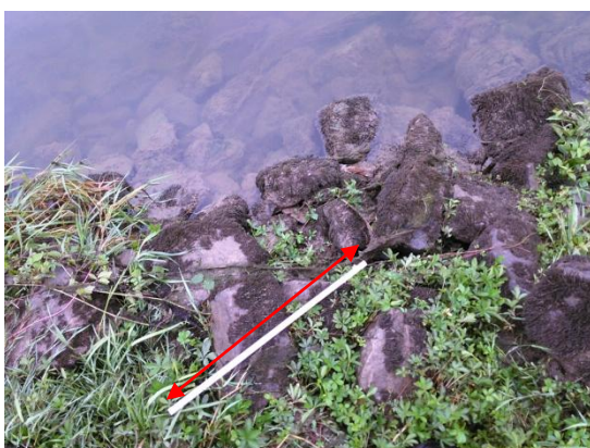
Figuur II.1 Stortsteen aan de waterlijn (rode pijl = 60 cm)
