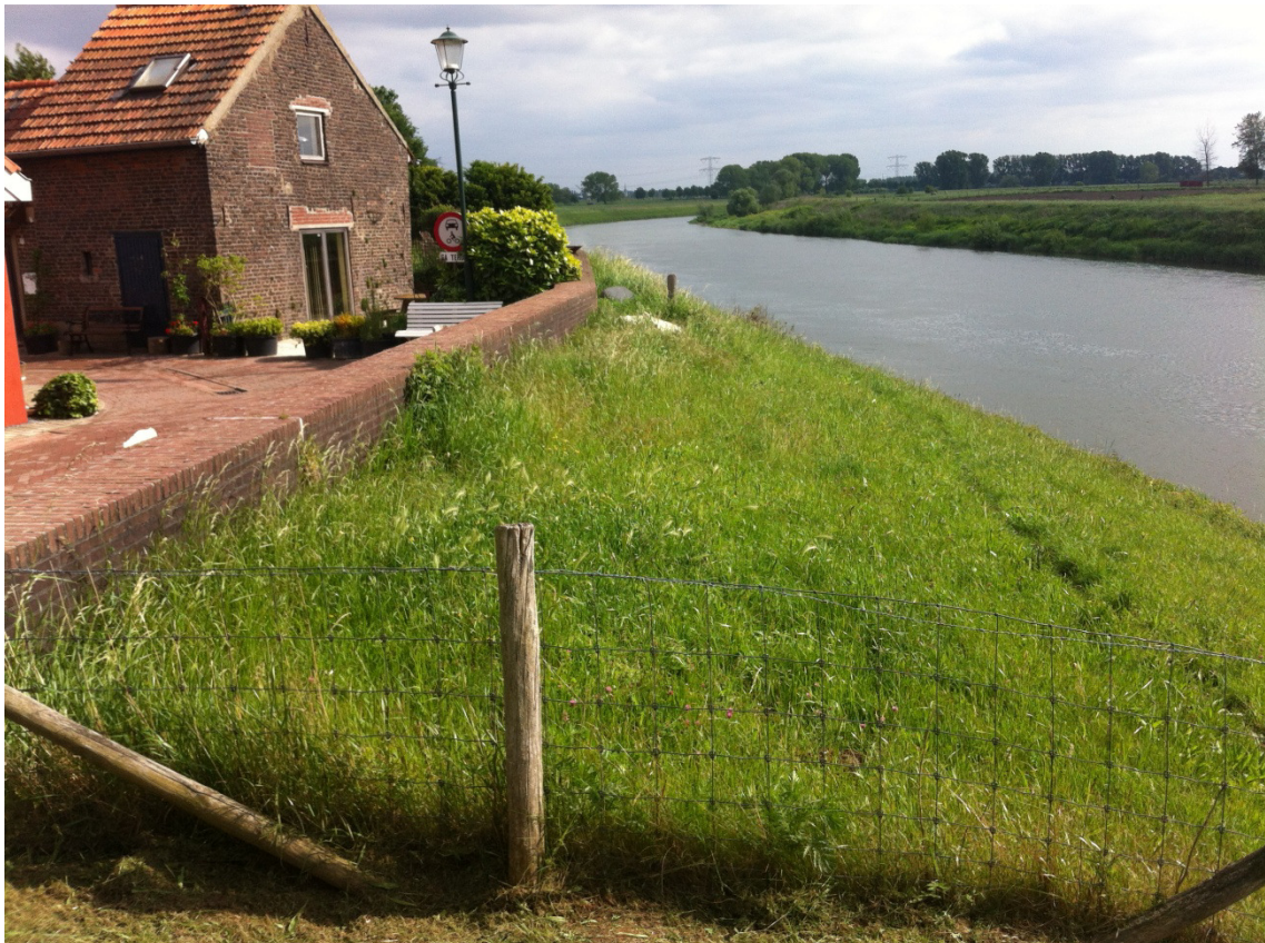
Figuur 2.6: Damwand met deksloof in dijkvak 50.540.3
