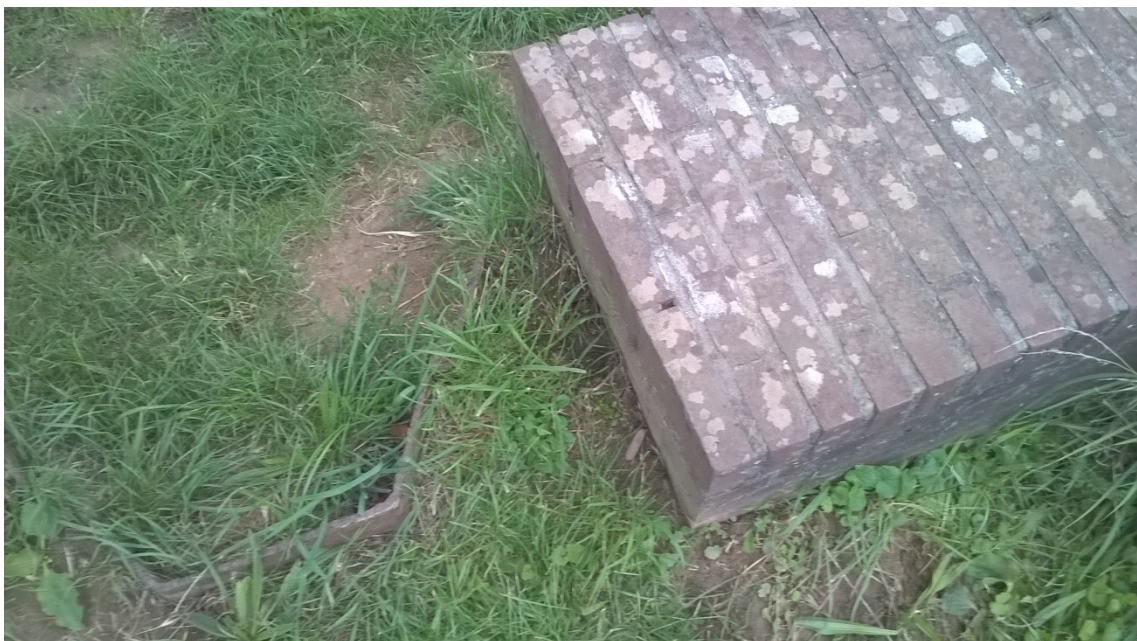
Figuur 2.7: Aanwezige damwand en deksloof in dijkvak 50.540.3
