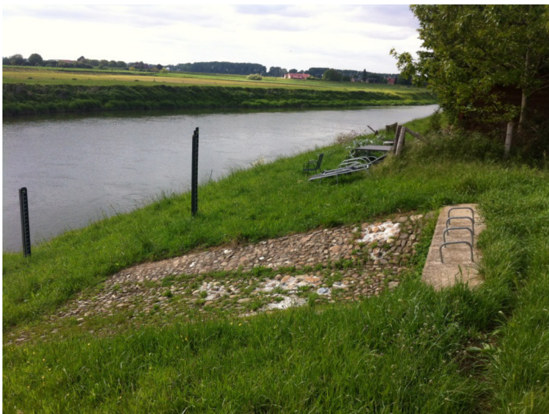
Figuur 2.5: Spoelgoot in dijkvak 50.540.2
