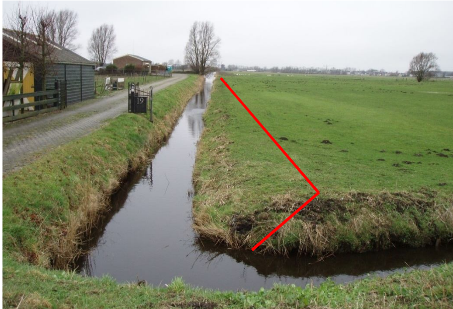
Figuur 1 Verbreden hoofdwatgang 210-058-00416
