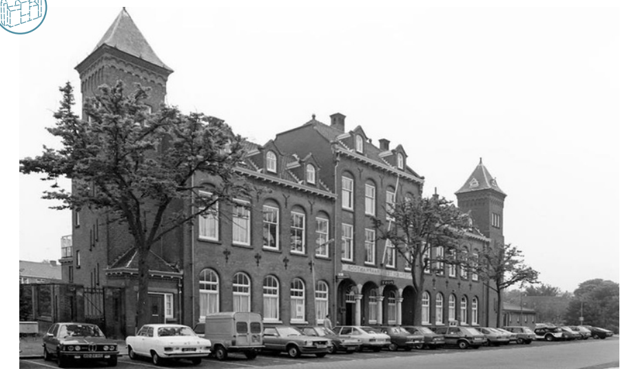
Het voormalige Postkantoor
