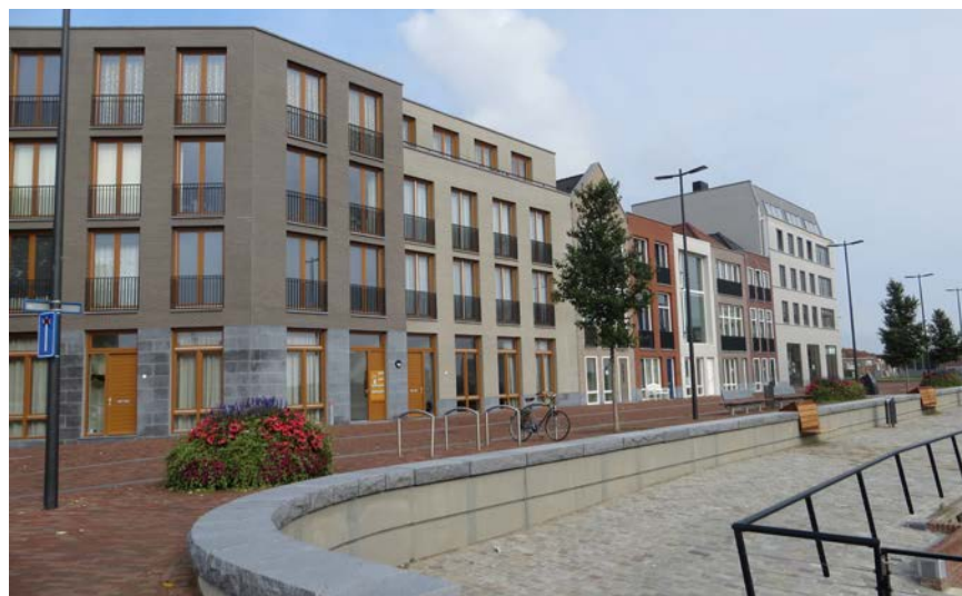
Referentie: bestaande inrichting van de Peperdijk
